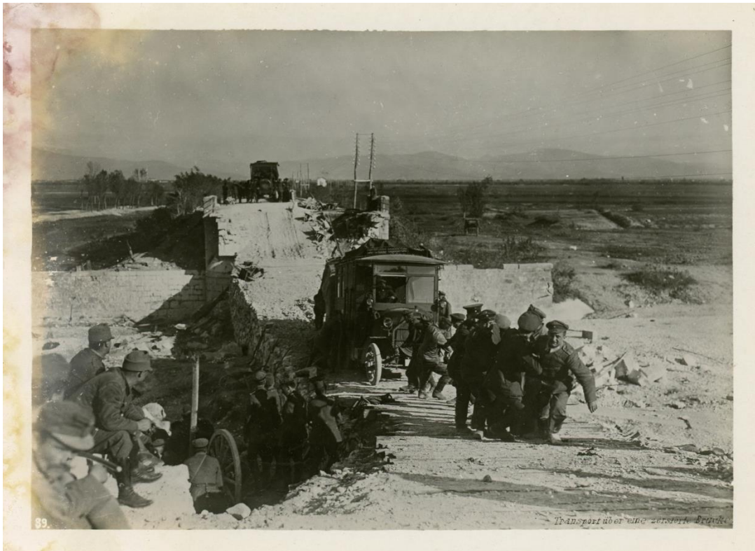
Abb. 7: Transport über zerstörte Brücke 27
